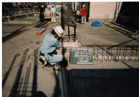
・ ガス圧接部超音波探傷試験
