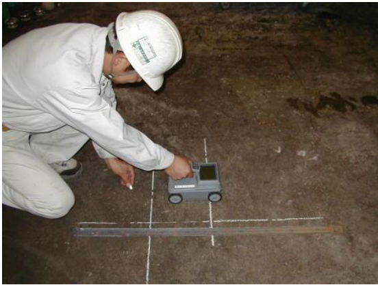
鉄筋の配筋 及び かぶり厚調査
